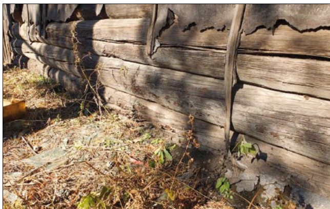
Рис. 5. Намокание стен деревянных домов
