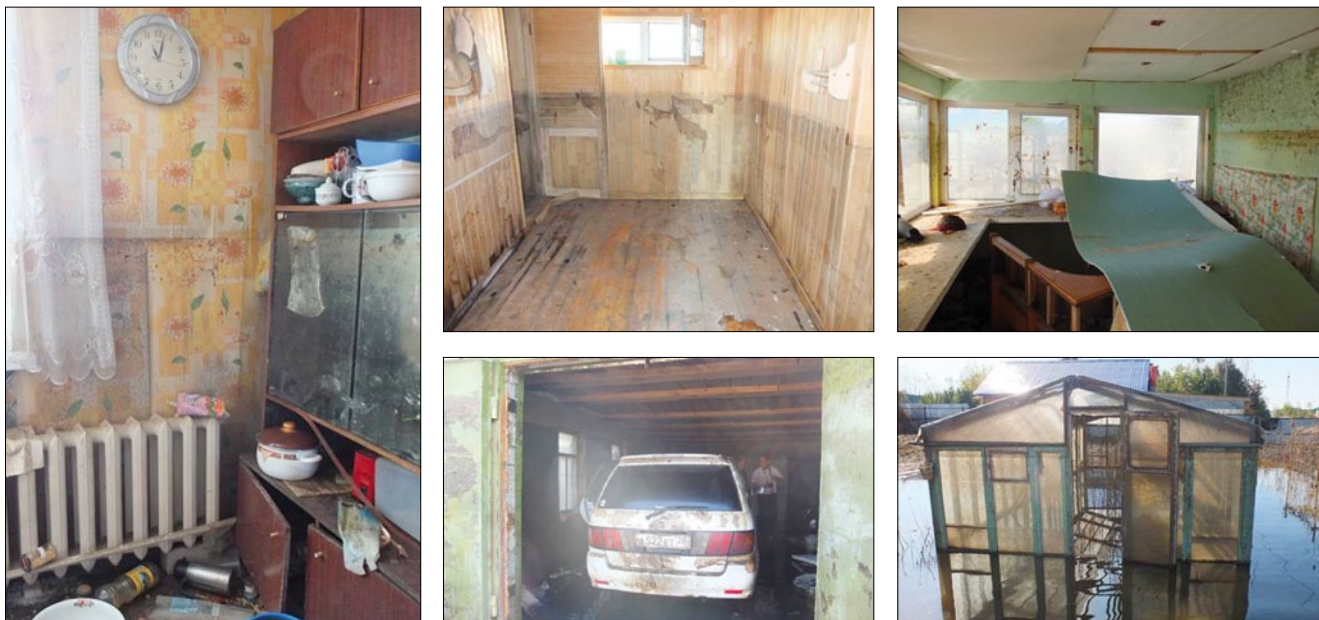
Рис. 8. Состояние помещений после наводнения
