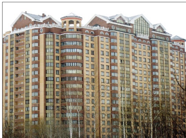
Рис. 4. Многоэтажный жилой дом в Красностуденческом проезде (Москва). На эксплуатируемой крыше расположены видовые площадки, творческие мастерские, спортивные залы. Фото Е.А. Туркиной
