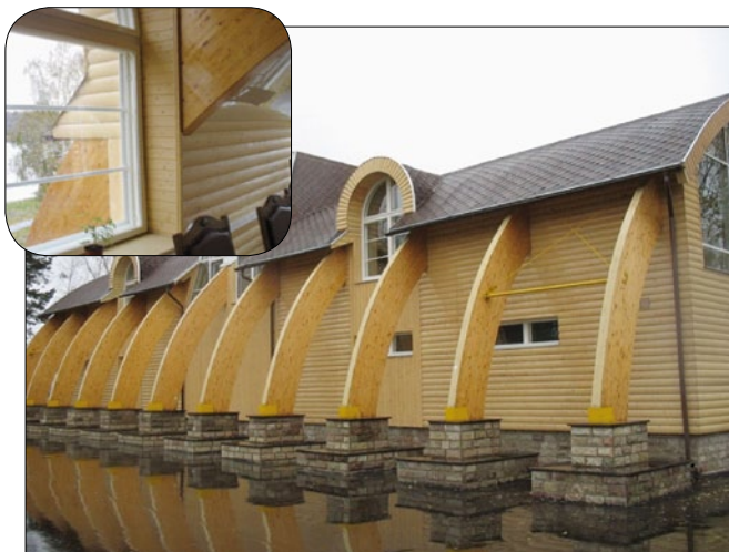
Рис. 3. Размещение клееных деревянных арок частично на открытом воздухе (дом отдыха «Торово», г. Череповец)
