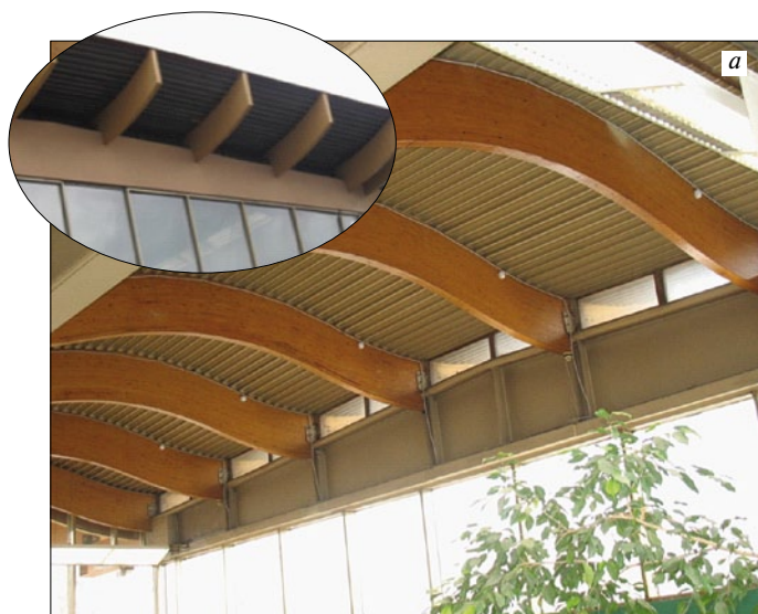
Рис. 5. Пересечение несущими КДК витража: а – бассейн «Чайка» (Москва); б – школа в районе Тропарево-Никулино (Москва)
