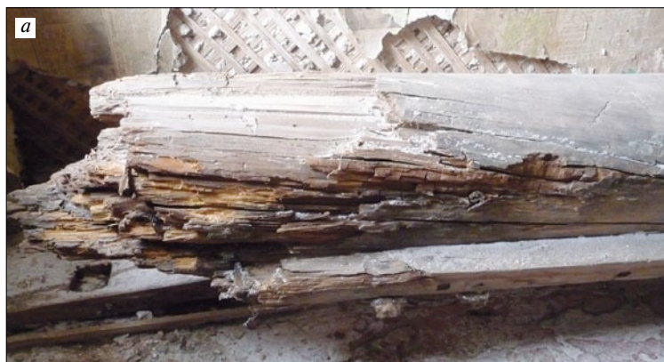
Рис. 1. Разрушение домовым грибом конца деревянной балки перекрытия (а) и пластины наката (б)
