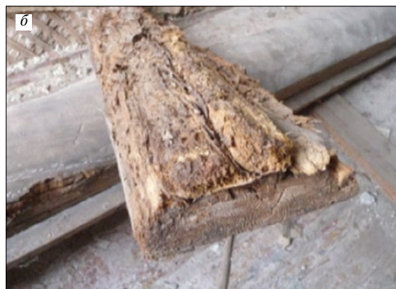
Рис. 1. Разрушение домовым грибом конца деревянной балки перекрытия (а) и пластины наката (б)
