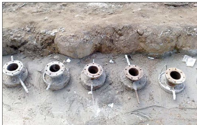
Рис. 4. Геотехнический барьер на пл. Тверской Заставы в Москве у дома № 1 по ул. Лесной
