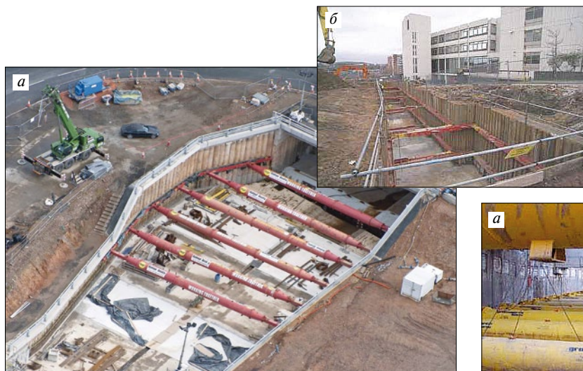
Рис. 1. Распорки с домкратами фирмы MGF: а – тоннель в г. Уэст-Бромидже; б – торговый комплекс в г. Виган (Великобритания)
