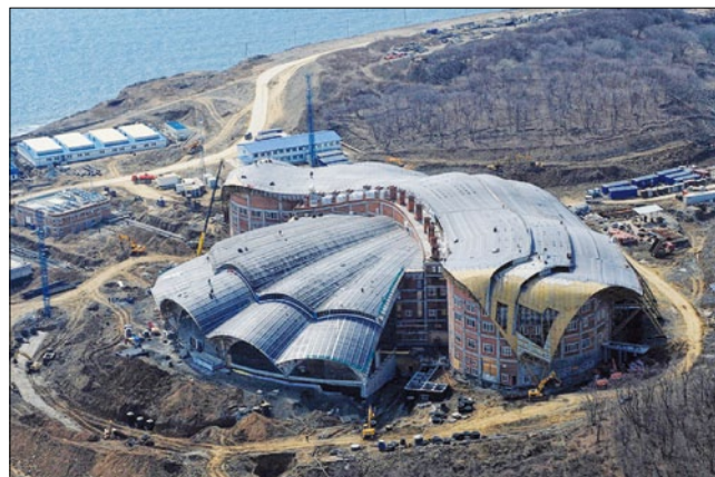
Рис. 11. Строительство Приморского океанариума на острове Русский
