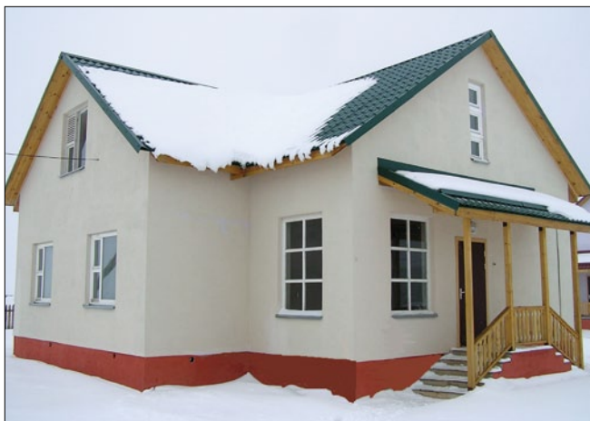
Рис. 1. Одноквартирный жилой сельский дом с наружными стенами из автоклавного газобетона
