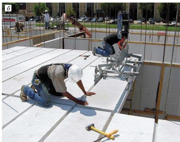
Рис. 1. Ячеисто-бетонные плиты перекрытий: а – спакетированные для транспортировки; б – монтаж плит на строительной площадке
