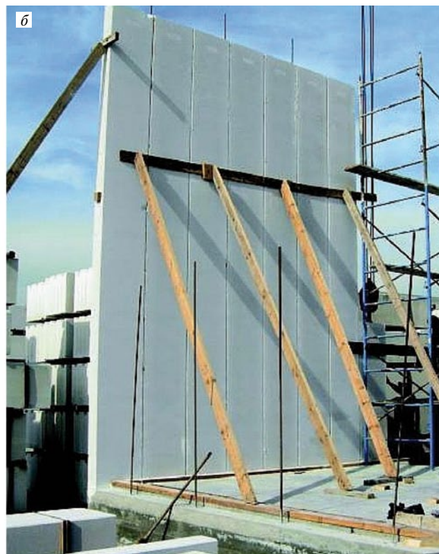
Рис. 3. Панели вертикальной разрезки с профилями «паз-паз»: а – спакетированные для транспортировки; б – в составе монтируемой стены
