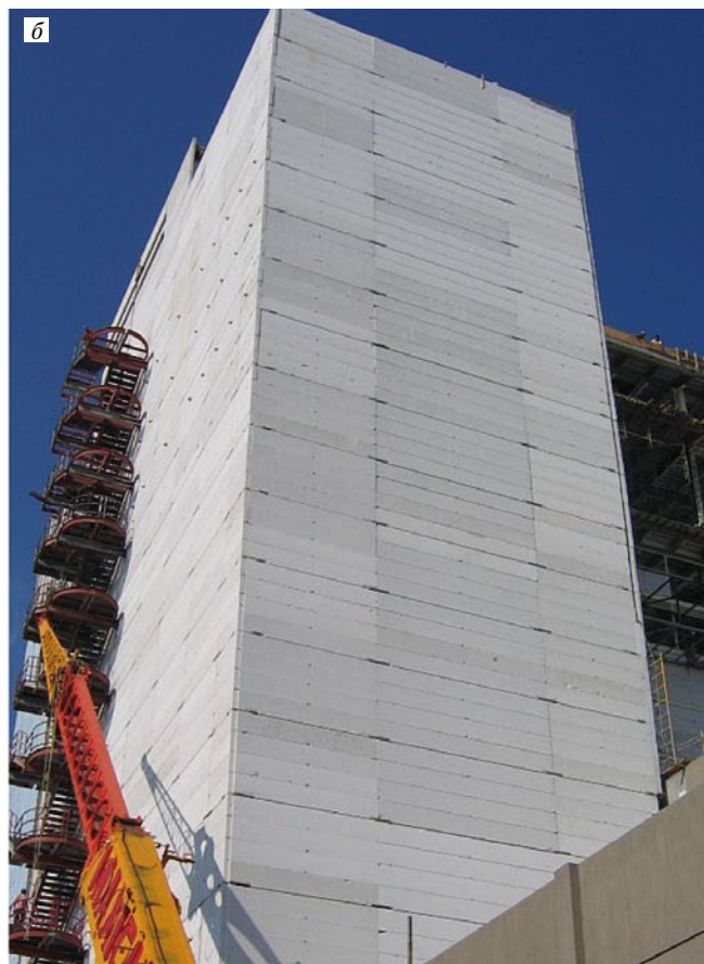
Рис. 4. Панели горизонтальной разрезки с профилями «паз-гребень»: а – спакетированные для транспортировки; б – в составе стены строящегося здания
