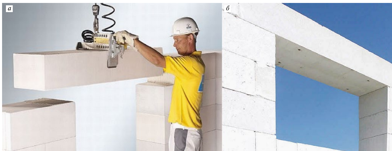
Рис. 7. Ячеисто-бетонные брусковые перемычки: а – в процессе монтажа; б – после установки в проектное положение
