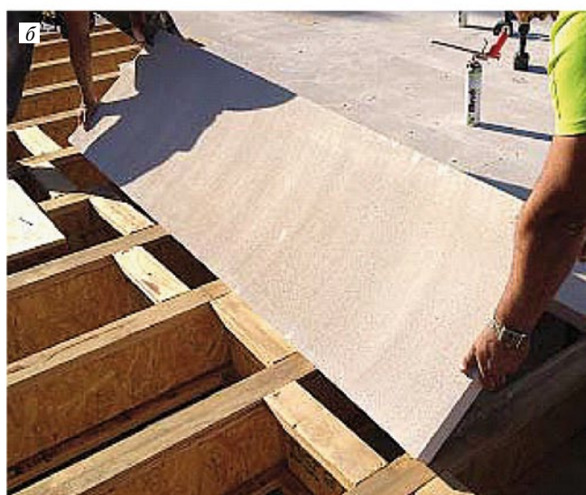
Рис. 1. Ячеисто-бетонные плиты перекрытий: а – спакетированные для транспортировки; б – монтаж плит на строительной площадке
