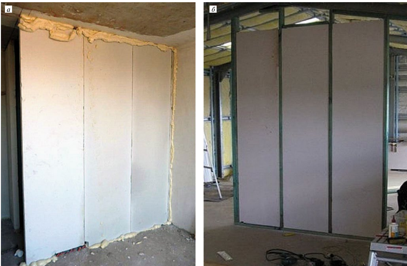
Рис. 6. Перегородочные панели в процессе монтажа: а – в составе бескаркасной перегородки; б – в качестве заполнения каркаса
