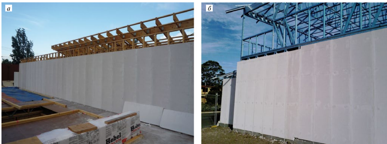
Рис. 5. Ячеисто-бетонные вертикальные панели в качестве обшивки деревянного (а) и стального (б) каркасов
