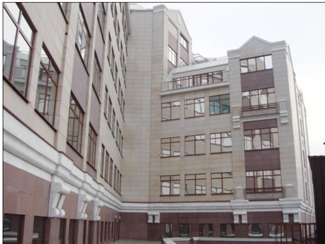
Рис. 1. Эксплуатируемое здание в центре Москвы с навесным вентфасадом и утеплителем из минераловатных плит
