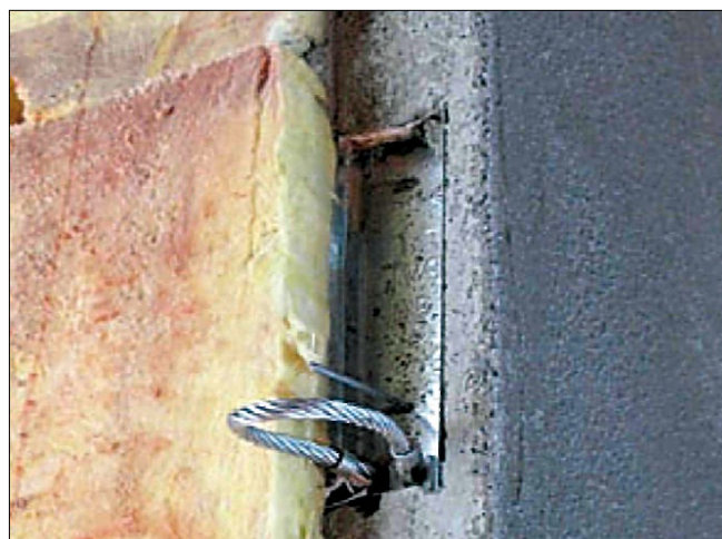
Рис. 5. Установка PVL в узкий стеновой элемент
