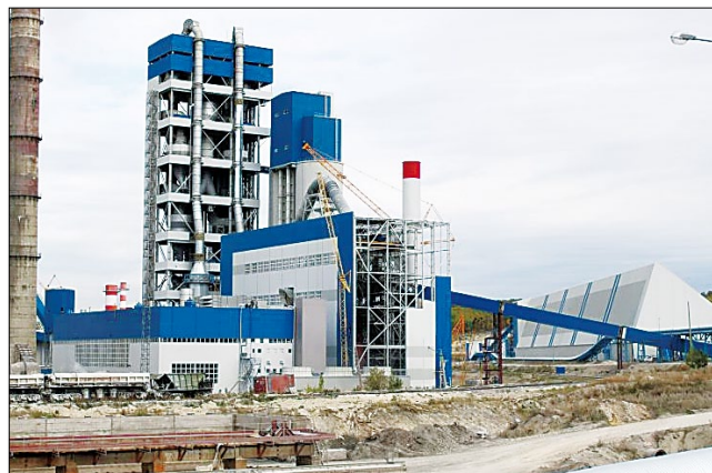
Новая технологическая линия сухого способа производства на «Мордовцементе»
