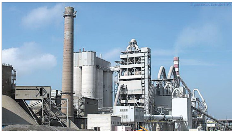
Общий вид Белорусского цементного завода
