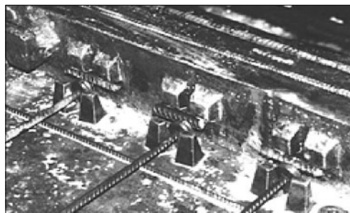
Рис. 5. Напрягаемые стержни с внутренними анкерами в упорах формы плиты перекрытия дома ПД-4
