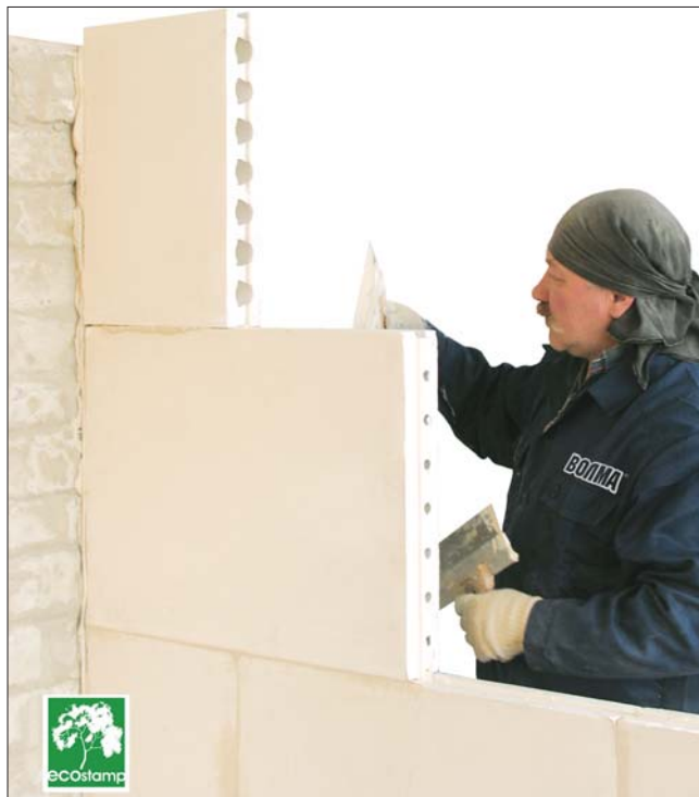
Рис. 2. Стена из пустотелой ВОЛМА-плиты
