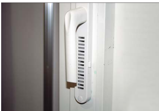
Приточный клапан, совмещенный с оконной ручкой
