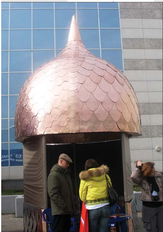
Из черепицы ЕВРАЗИЯ можно выполнить уклонную крышу и сложную купольную конструкцию
