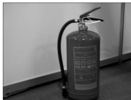
Новый огнетушитель, разработанный ООО «Темперо», предназначен для твердых и жидких горючих материалов, тушения электрооборудования, находящегося под напряжением до 1000 В, а также для работы при пониженных температурах до –30°C
