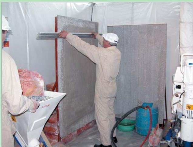
Все тонкости механизированного нанесения штукатурных растворов на основе ССС продемонстрировали непосредственно на стенде специалисты компании «Стило». Для демонстрации использовалась штукатурная смесь ШГМ от ОАО «Сода» (г. Стерлитамак) и штукатурная машина компании «m-tec» (Германия)
