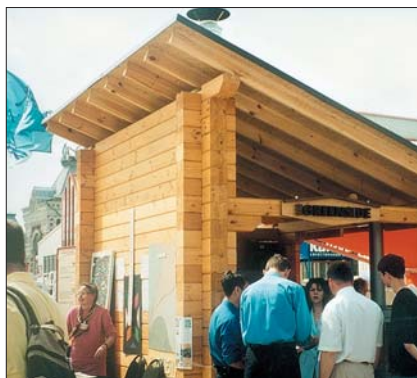
Стенд компании «Greenside» на открытой площадке был построен из клееных деревянных конструкций собственного производства
