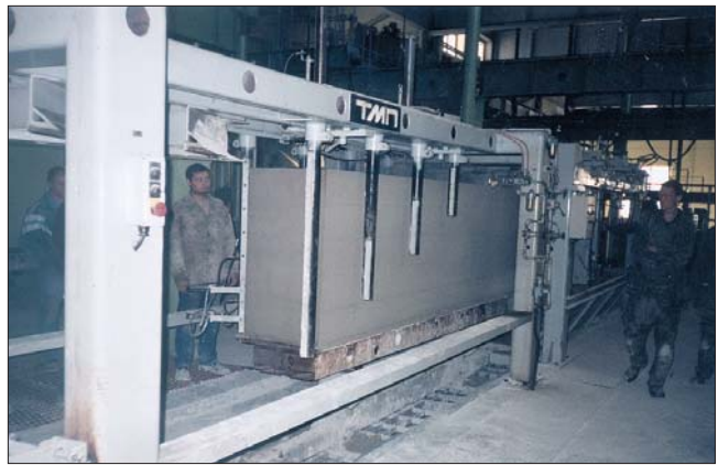
Резательный комплекс линии по производству ячеисто-бетонных блоков
