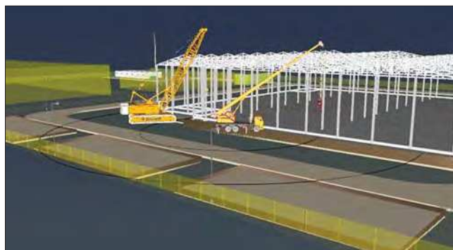
Рис. 6. Производство работ на этапе возведения надземной части Fig. 6. Production of works at the stage of construction of the above-ground part
