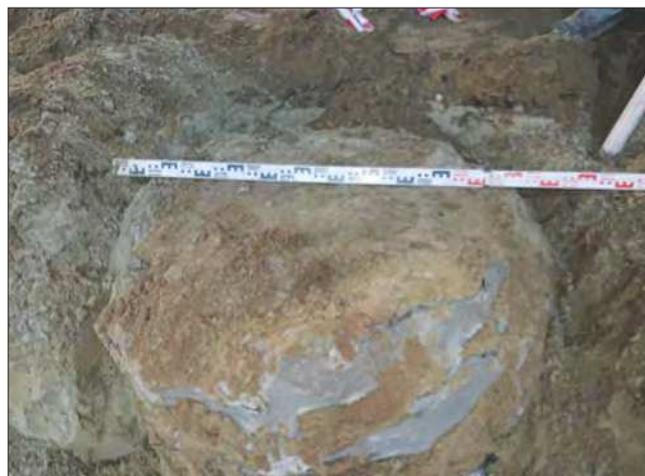
Рис. 7. Контроль диаметра грунтоцементного элемента
