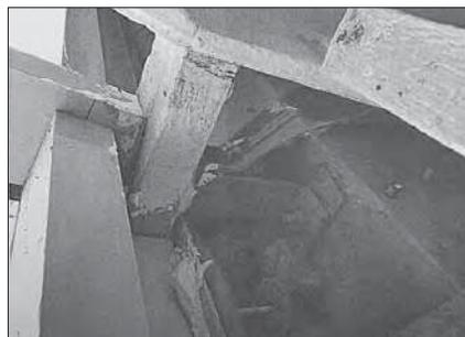
**Рис. 2.** Узел витражной системы блока на подконструкции парапета
