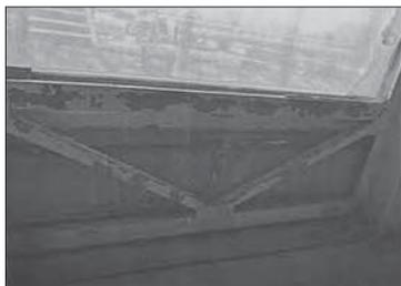
**Рис. 4.** Локальные участки отслоения защитного покрытия металлоконструкций и следы коррозии металла
