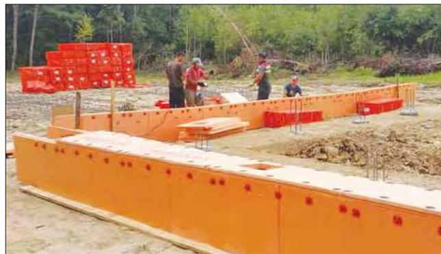
**Рис. 3.** Сборка несъемной опалубки
