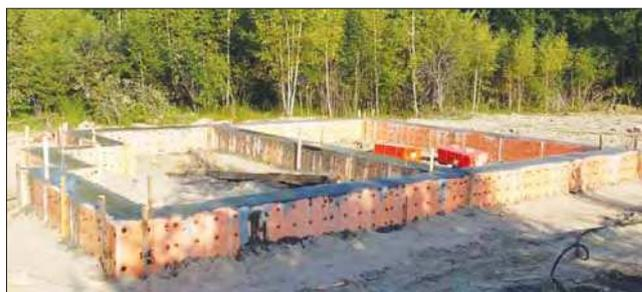
**Рис. 8.** Конструкция после заливки
