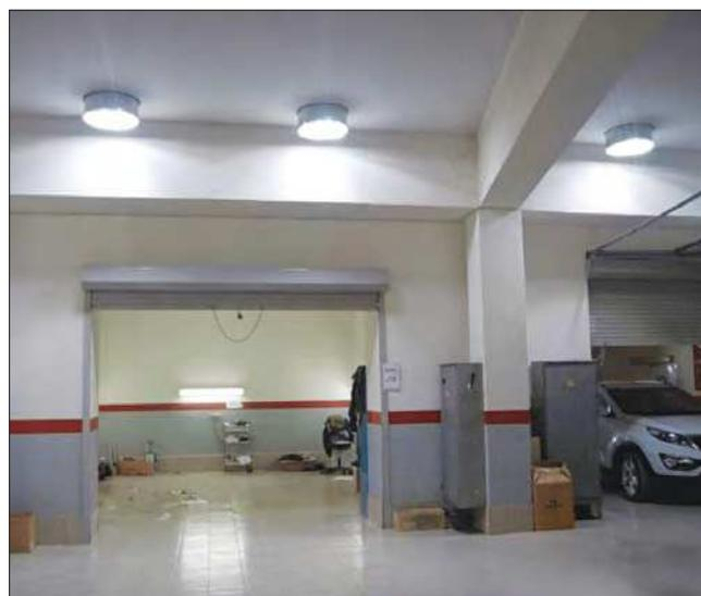
*Рис. 3. Проект естественного освещения подземной установки системой Solatube®, реализованный в России на станции технического обслуживания в г. Сочи*
