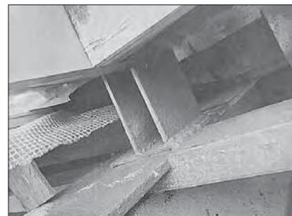
**Рис. 3.** Узел крепления витражной системы к колонне
