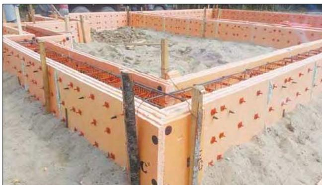
**Рис. 5.** Укрепление угловых элементов опалубки
