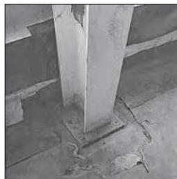
**Рис. 5.** Отсутствие анкеров для крепления колонны к основанию
