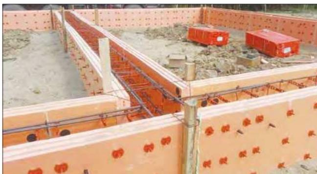
**Рис. 6.** Схема усиления T-образных элементов опалубки
