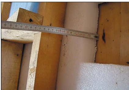
Рис. 2. Место отбора проб и фрагментов соснового бруса в наружной стене здания
