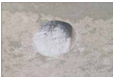
Рис. 4. Технологические отверстия в оболочке, через которые нагнетается вспученный перлит
