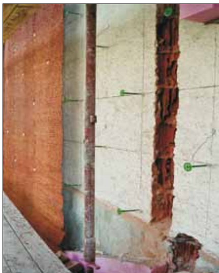
Рис. 1. Крепление металлокерамической сетки
