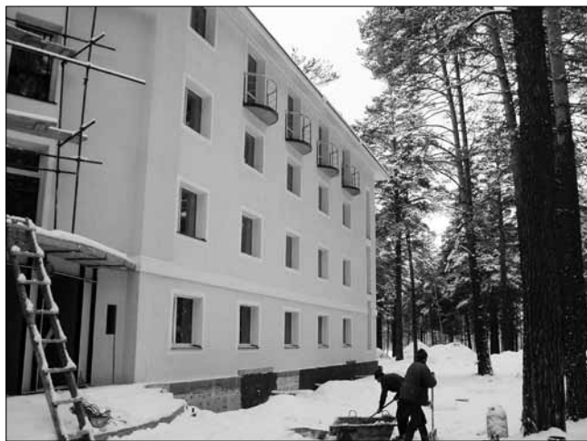
Рис. 3. Фактурная облицовка фасада здания, выполненная из рекомендуемых составов сухих смесей
