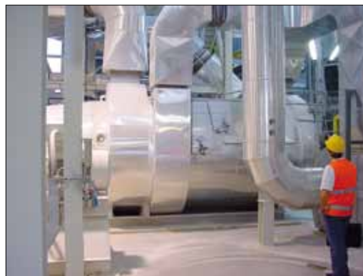
Рис. 12. Генератор горячих газов с различными рециркуляционными газовыми потоками
