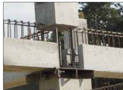
Рис. 5. Единая неразрезная сборно-монолитная конструкция каркаса
