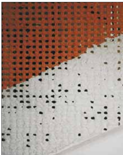
Рис. 2. Штукатурный слой по металлокерамической сетке
