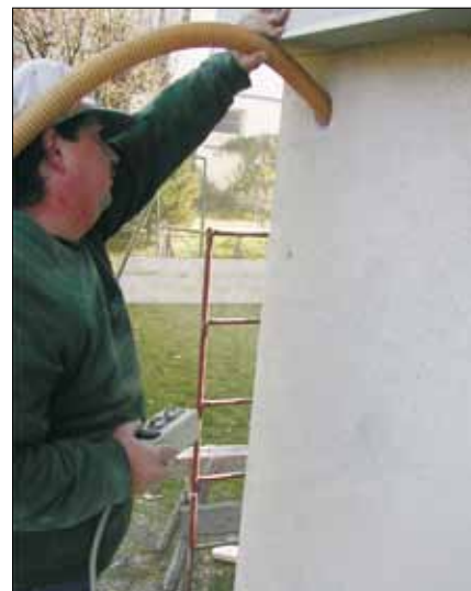
Рис. 3. Заполнение пространства между оболочкой и стеной вспученным перлитом
