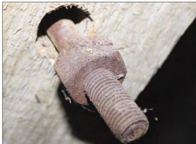
**Рис. 1.** Болтовое соединение составной деревянной балки стропильной конструкции здания учебного корпуса № 2 Поволжского государственного технологического университета после 60 лет эксплуатации
