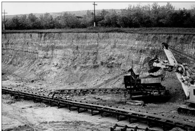
Циклично-поточная технология разработки вскрышных пород. Оборудование технологической линии изготовлено институтом. Багураевское карьероуправление (фото Г.Р. Буткевича)
