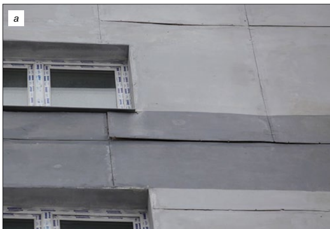
Рис. 4. Увеличение зазоров в стыках между листами и локальные отрывы СМЛ (а, б). Коробление и поперечный разрыв листов наружной обшивки здания (б)
