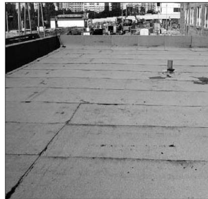
**Рис. 6.** Основной водоизоляционный ковер кровли
