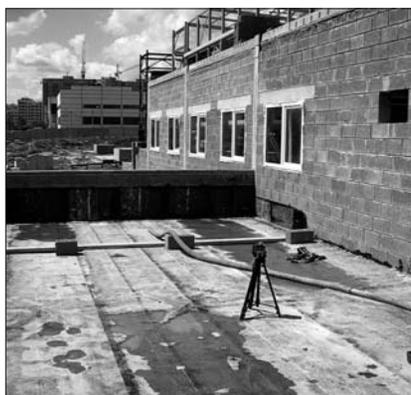
Рис. 2. Пароизоляционный слой кровли, обустроенный рубероидом, наклеенным на горячую мастику. Тип пароизоляции В-2, СНИП II-26–76
