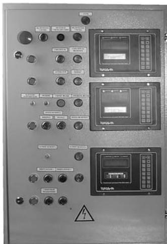
Рис. 1. Пульт автоматизированного управления БСУ
