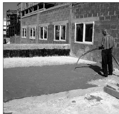
Рис. 3. Устройство теплоизоляционной обложки кровли из монолитного пенобетона марки по средней плотности Д300
