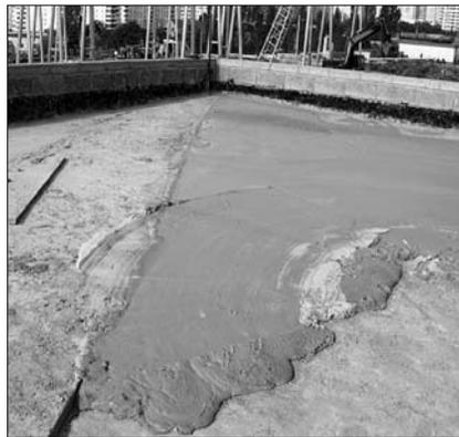
**Рис. 5.** Устройство основания из монолитного пенобетона марки по средней плотности Д800 для наклейки рулонных материалов
