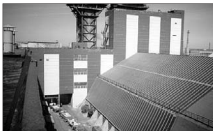
Рис. 1. Кровля склада аммиачной селитры комбината минеральных удобрений ОАО «Дорогобуж», выполненная из Элона
