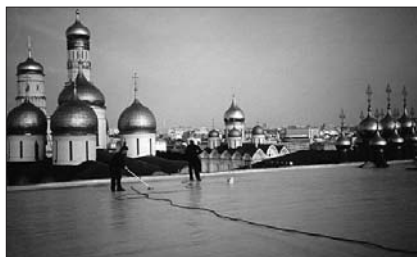
Рис. 2. Кровля Государственного Кремлевского Дворца, выполненная из Кровлелона с защитным окрасочным покрытием
