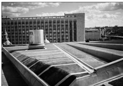
Кровля из материала Элон® выполнена на крыше Гостиного двора в Москве
