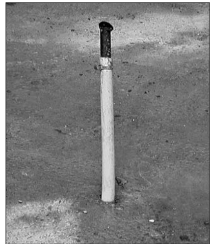
Рис. 2. Контрольно-инъекционная трубка
