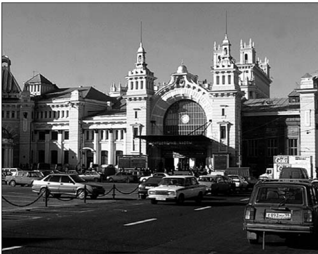
Рис. 1. Ремонт металлической кровли Белорусского вокзала, Москва
