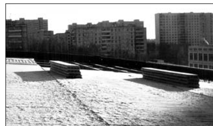
Рис. 2. Сборка кровли из монопанелей возможна и в зимнее время
