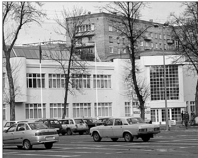
Рис. 2. Устройство кровли павильона «Триумф», Росстройэкспо, Москва
