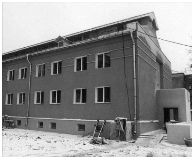
Монтаж системы «Шуба плюс» можно производить даже при отрицательной температуре
