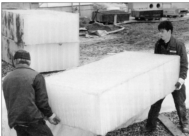
Рис. 1. Такую «механизацию» можно применять при укладке блоков Rigo-fill в ливневую канализацию
