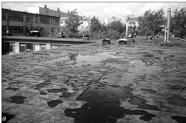
Кровля с большим количеством узлов примыканий до ремонта (а) и после ремонта (б) материалами ВНИИстройполимер
