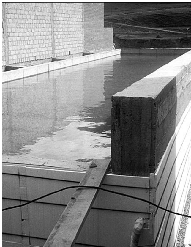
Испытания на водонепроницаемость железобетонной чаши бассейна размером 25×6 м, изготовленной с применением минеральной расширяющей добавки к цементу «ИР-1» (г. Владикавказ).
