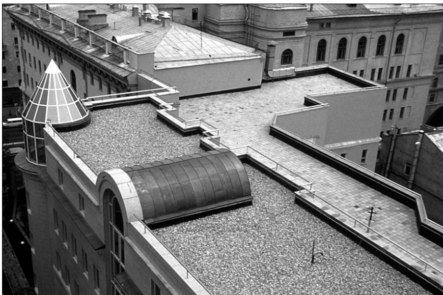
Рис. 1. Здание Мэрии, Москва. Балластная система (Темпстрой): 800 м 2 эксплуатируемая крыша с тротуарной плиткой; 400 м 2 крыша с балластом из гальки фракции 20–40 мм
