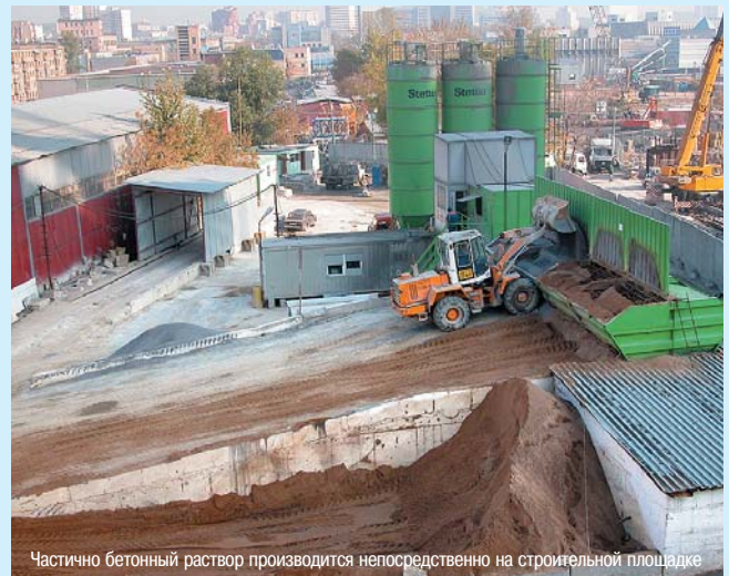
Частично бетонный раствор производится непосредственно на строительной площадке
