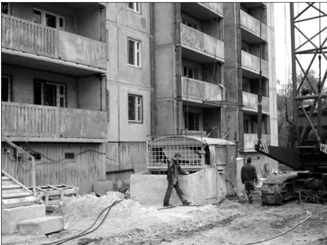
Традиционный подход к штукатурным работам
