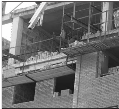
Рис. 2. Строящийся жилой дом со стенами из фибропенобетонных блоков
