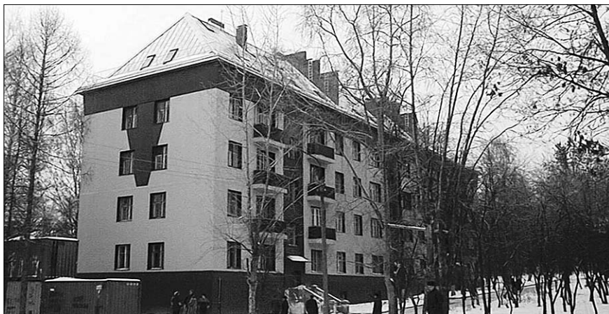
Рис. 2. Успешная реализация пилотного проекта по реконструкции дома одной из первых массовых серий с надстройкой мансарды в г. Лыткарино Московской области
