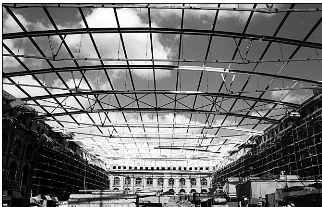
Рис. 1. Реконструкция Гостиного Двора на этапе монтажа несущих стальных конструкций
