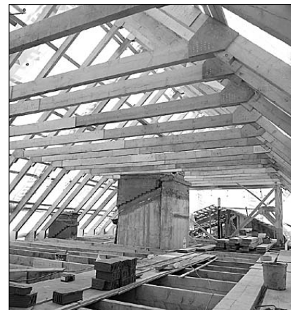
Рис. 3. При реконструкции дома в г. Лыткарино для изготовления несущих конструкций мансарды было выбрано дерево
