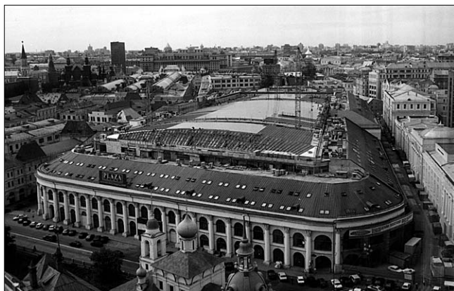
Рис. 2. Монтаж стеклопакетов атриума Гостиного Двора
