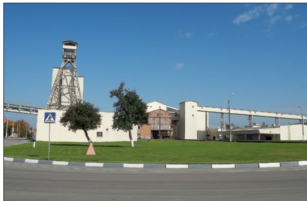
Современная территория завода
