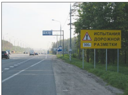
Рис. 1. Общий вид участка автомобильной дороги М-2 «Крым», км 37–39, прямое направление (22.05.2012 г., до нанесения контрольных линий)
