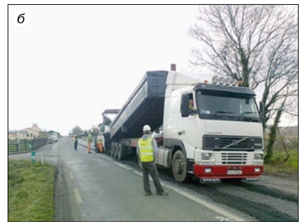
Рис. 8. Распределение асфальта (а) и укладка асфальтобетона (б)
