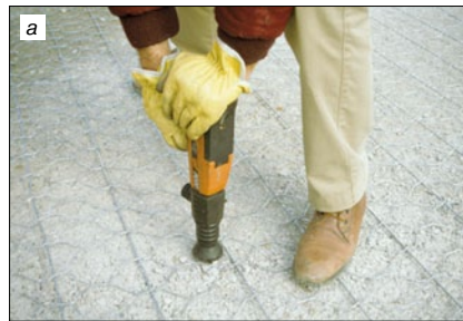
Рис. 9. Пристрелка сетки дюбелями (а) и финал фиксации сетки Родмеш (б)
