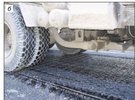
Рис. 10. Разлив эмульсии (а) и застывшая битумная эмульсия (б)
