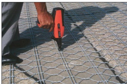
Рис. 2. Укладка сетки Родмеш при устройстве покрытия автодороги
