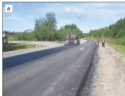
Рис. 10. Разлив эмульсии (а) и застывшая битумная эмульсия (б)
