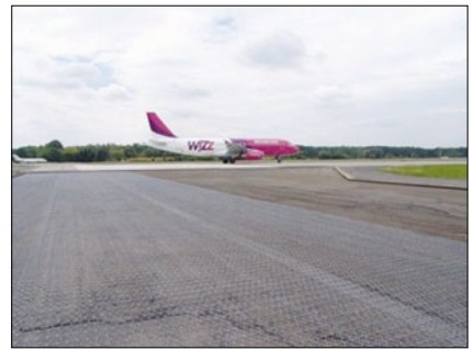
Рис. 7. Капитальный ремонт взлетно-посадочной полосы
