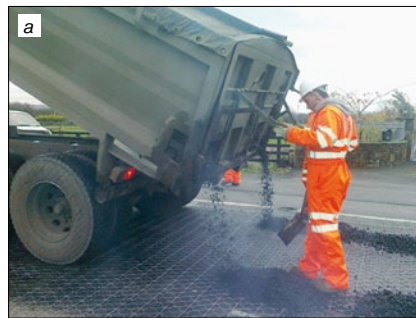
Рис. 8. Распределение асфальта (а) и укладка асфальтобетона (б)
