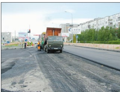
Рис. 6. Перекресток ул. Мира и ул. Ленина, монтаж сетки (г. Сургут)
