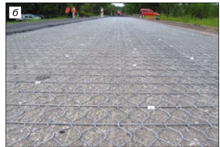
Рис. 9. Пристрелка сетки дюбелями (а) и финал фиксации сетки Родмеш (б)
