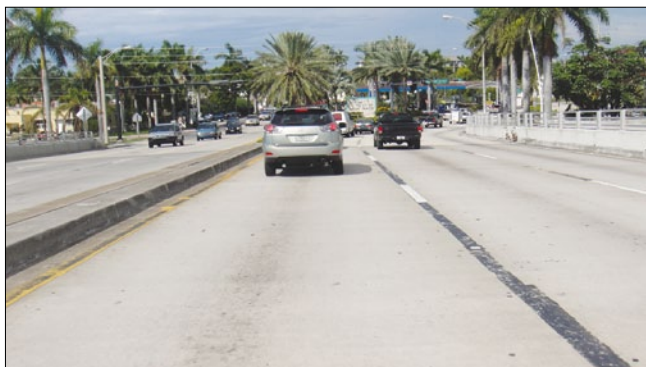
Рис. 3. Закрашивание черным цветом белых и желтых линий разметки
