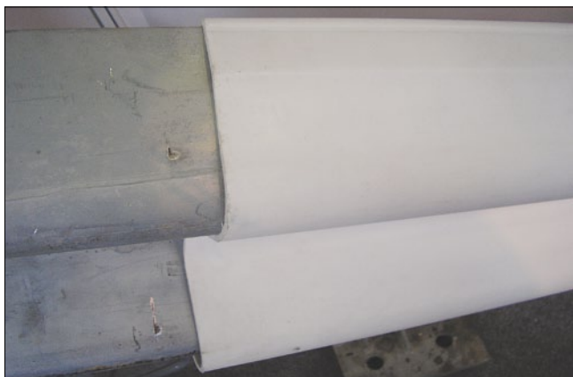
Рис. 5. Расположение защитной пластиковой панели на дорожном ограждении
