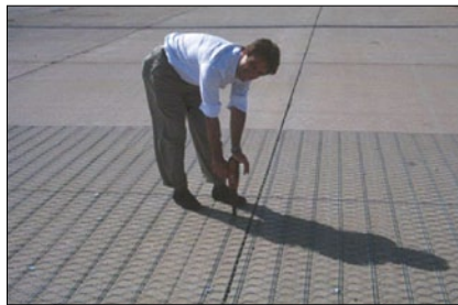
Рис. 2. Укладка сетки Родмеш при устройстве покрытия автодороги
