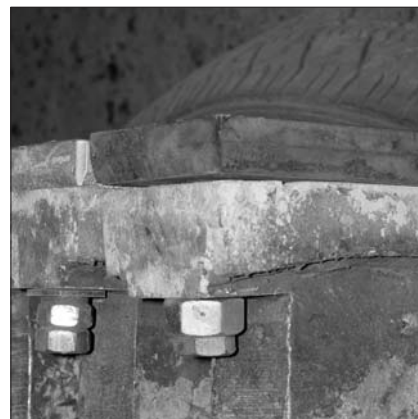
Рис. 3. Плита головки штампа установлена на криволинейную поверхность, что обуславливает работу пластины на излом
