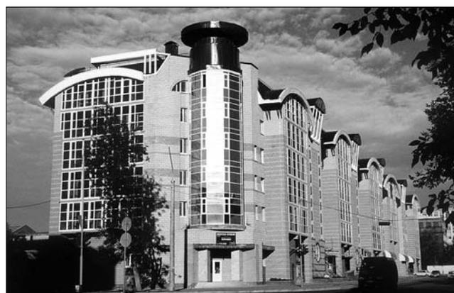
**Рис. 4.** Жилой дом по ул. Социалистической (Уфа). Несущий слой стен – высокопустотные вибропрессованные бетонные блоки, утеплитель – минераловатные плиты, облицовочный слой – цветные сплитерные бетонные блоки
