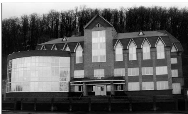
**Рис. 3.** Административно-бытовое здание лыжероллерной трассы «Биталон» (Уфа). Несущий слой стен – пустотелые вибропрессованные бетонные блоки, утеплитель – минераловатные плиты, облицовочный слой – сплитерные и гладкие бетонные блоки
