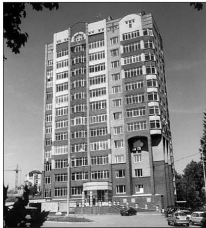
**Рис. 6.** Жилой дом с мансардой по ул. Дорофеева (Уфа). Несущий слой стен – полнотелые и пустотелые вибропрессованные блоки, утеплитель 100 мм, облицовочный слой – сплитерные цветные блоки с опиранием на железобетонный опорный пояс
