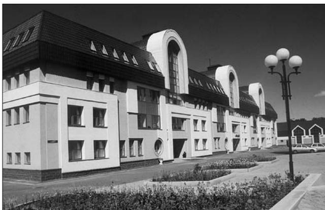
Рис. 1. Всероссийский центр глазной и пластической хирургии. Несущие стены выполнены из керамического кирпича, система теплоизоляции – плитный утеплитель, оштукатуренный по сетке
