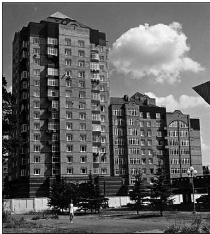
**Рис. 5.** Жилые дома по ул. Крупской (Уфа). Несущий слой стен – полнотелые вибропрессованные бетонные блоки, утеплитель – минераловатные плиты Rockwool, облицовочный слой – сплитерные пустотелые цветные блоки
