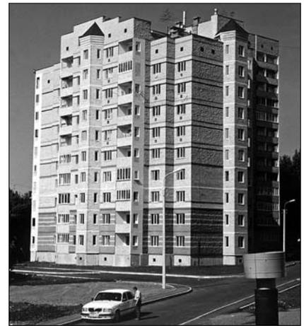
**Рис. 7.** Жилой дом серии 121у по пр. Октября (Уфа). Несущий слой стен – железобетонные панели толщиной 140 мм, теплоизоляционный слой – минераловатные плиты толщиной 200 мм, облицовочный слой – цветные вибропрессованные блоки
