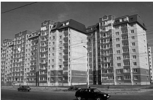
Жилой дом в микрорайоне Сипайлово серии 121у. Несущий слой стен – железобетонные панели толщиной 140 мм, теплоизоляционный слой – минераловатные плиты толщиной 200 мм, облицовочный слой – лицевой керамический кирпич
