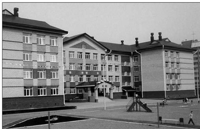
Рис. 2. Общеобразовательная школа в микрорайоне Сипайлово (Уфа). Несущая часть стены выполнена из высокопустотных вибропрессованных бетонных блоков. Облицовочный слой – цветные сплитерные бетонные блоки
