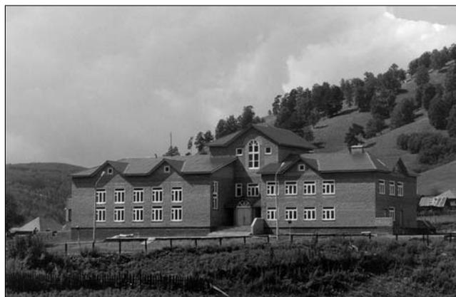
Школа в с. Усмангали Белорецкого р-на Республики Башкортостан на 108 учащихся. Несущий слой стен – пустотелые вибропрессованные бетонные блоки, эффективный утеплитель, облицовочный слой – сплитерные бетонные блоки
