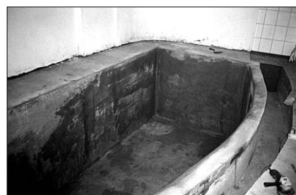
Рис. 2. Законченная гидроизоляция бассейна, выполненная материалом Гидро-S, до производства отделочных работ.
