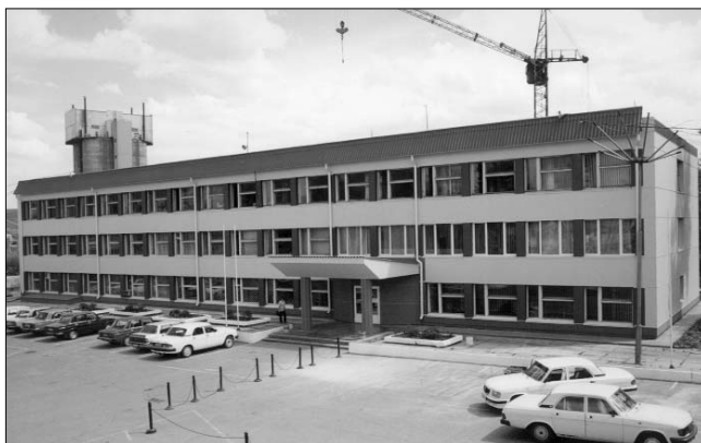
Здание заводоуправления ОАО «Волна» отделано только материалами собственного производства
