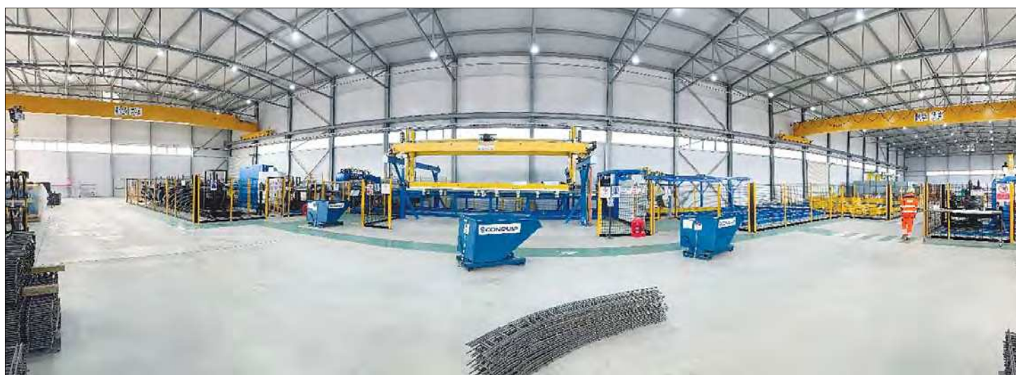
Заводской цех проекта Strabag North Yorkshire Polyhalite с установками Progress
