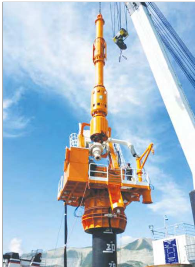
Рис. 2. Установка BUMA для бурения с эрлифтом в погруженной обсадной трубе ( https://koper.pro/drilling-rig-rcd/ )
