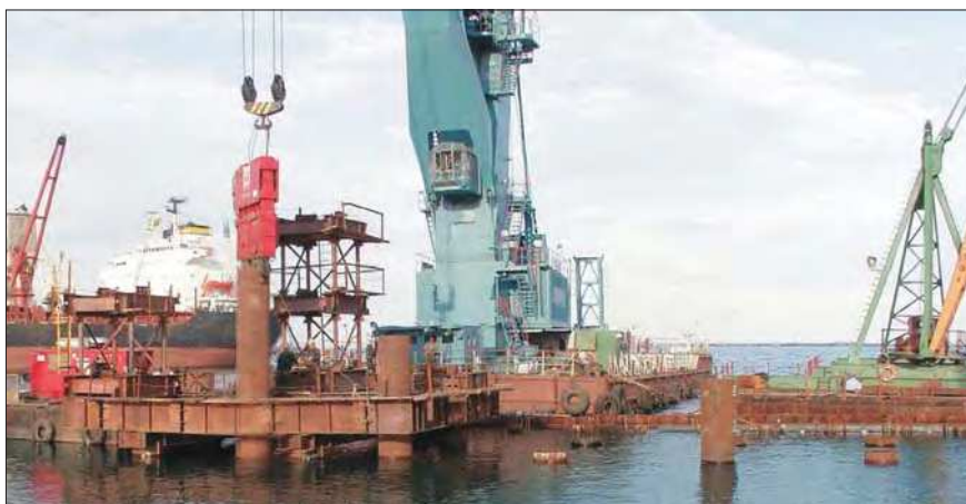
Рис. 1. Погружение обсадной трубы вибропогружателем, подаваемым плавучим краном ( http://www.rla.com.ua/upload/catalog/5be44b37594006f131f58836366902be.pdf )
