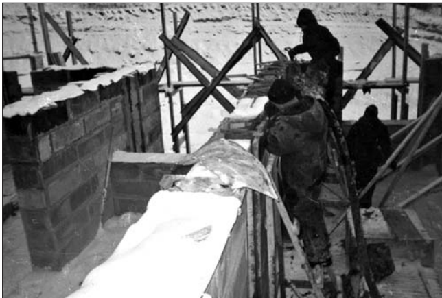
Технология возведения малоэтажных домов «СОВБИ» из пенобетона позволяет проводить работы при отрицательной температуре
