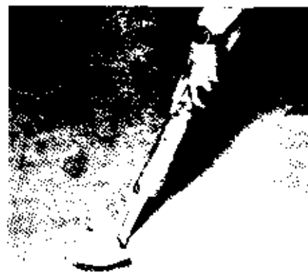
Рис. 1. Установка (УМГ) для приготовления и подачи гипсовой смеси к месту устройства наливных самонивелирующихся гипсовых стяжек под полы
