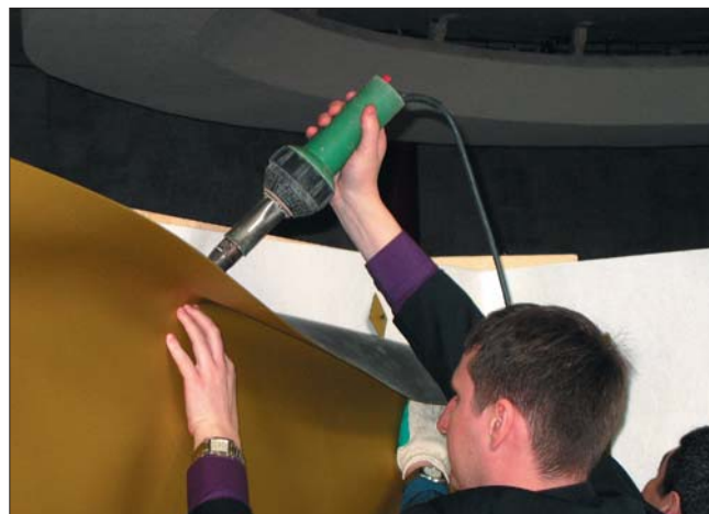
Технология крепления полимерных мембран Sikarlap на вертикальную поверхность
