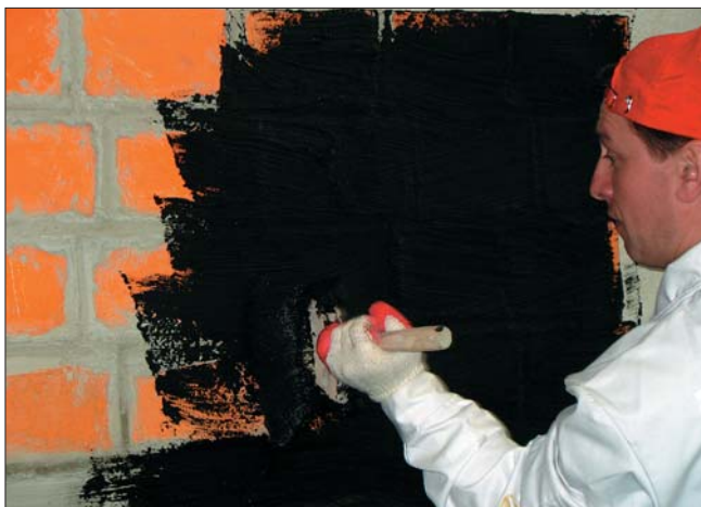
Натурный показ нанесения битумно-полимерной мастики COMBIFLEX
