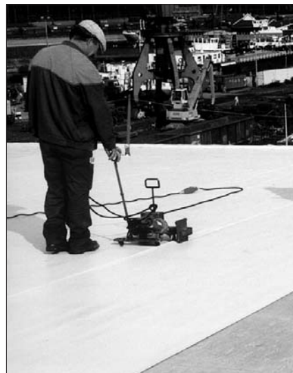
Сварка кровельных материалов горячим воздухом позволяет создать практически герметичное покрытие
