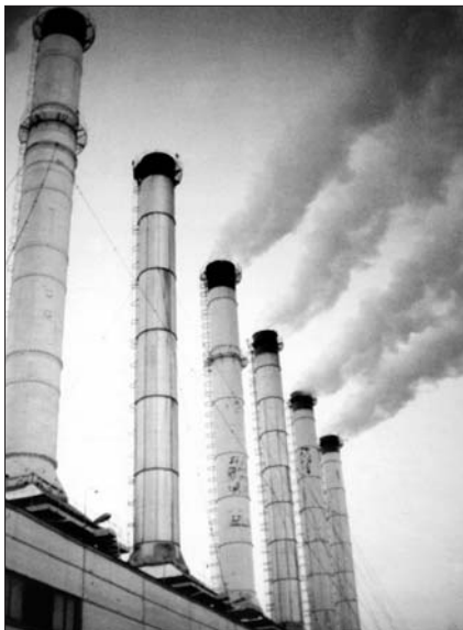
Рис. 4. Стеклопластиковые трубы, изготовленные на ФГУП «Авангард» методом намотки
