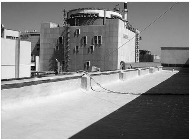
Ремонт кровли Волгодонской АЭС
