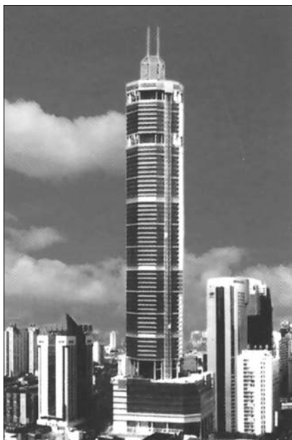
Рис. 1. Здание с каркасом из трубобетона на площади Сайгэ в Шэньчжэне, КНР
