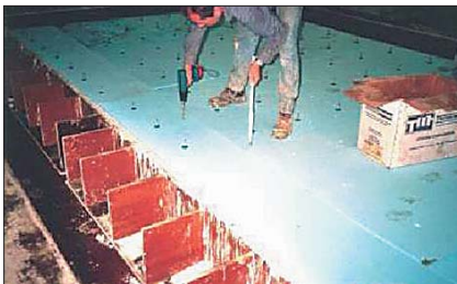
Монтаж системы STYRODOM
