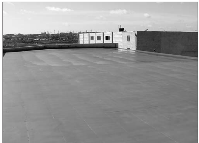
Обустройство новой кровли
