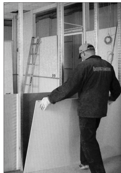
Монтаж гипсопласта производится по оцинкованному профилю аналогично обычным гипсокартонным листам
