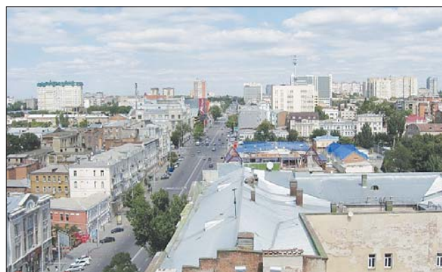
Рис. 9. Крыши Ростова-на-Дону Fig. 9. Roofs of Rostov-on-Don
