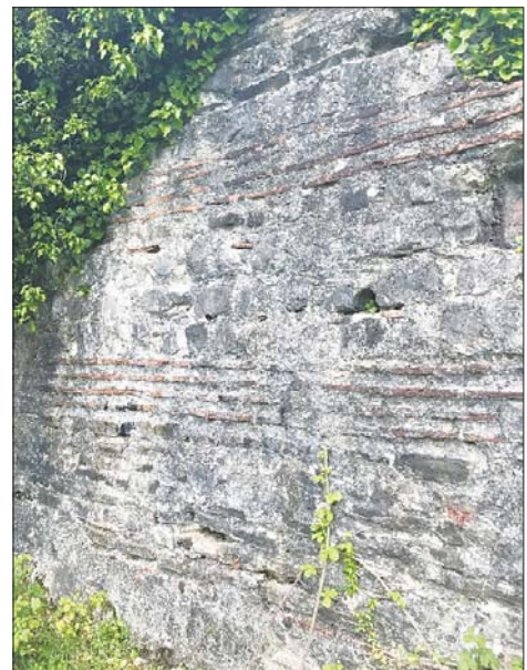
Рис. 3. Фрагменты кирпичной кладки на известковом растворе на объектах архитектурного наследия Абхазии (слева – Анакопия, воротная башня, X в.; справа – Бзыбская крепость, стена, VIII в.) Fig. 3. Fragments of brickwork on lime mortar on the objects of the architectural heritage of Abkhazia (on the left – Anakopia, gate tower, X century, on the right – Bzyb fortress, wall, VIII century)
