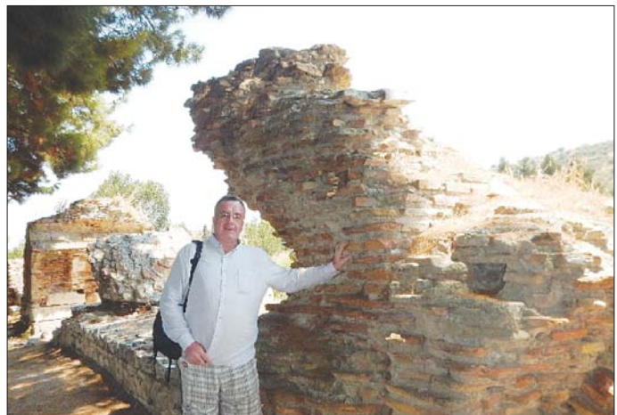
Рис. 2. Полуразрушенная кирпичная кладка на известковом растворе в древнем городе Эфес (Турция, II в.) Fig. 2. Dilapidated brickwork on a lime mortar in the ancient city of Ephesus (Turkey, II century AD)
