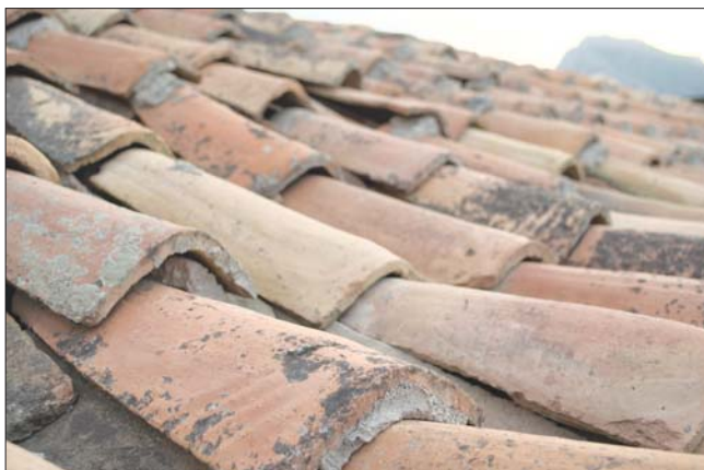
Рис. 3. Укладка черепицы на раствор Fig. 3. Laying tiles for mortar
