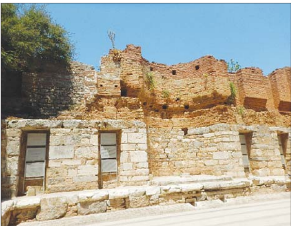
Рис. 2. Полуразрушенная кирпичная кладка на известковом растворе в древнем городе Эфес (Турция, II в.) Fig. 2. Dilapidated brickwork on a lime mortar in the ancient city of Ephesus (Turkey, II century AD)
