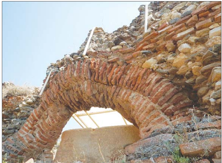
Рис. 4. Полуразрушенный кирпичный свод на известковом растворе в древнем городе Сардис (Турция, IV–V вв.) Fig. 4. A dilapidated brick vault on lime mortar in the ancient city of Sardis (Turkey IV–V century)
