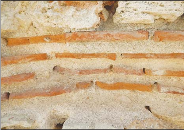
Рис. 1. Фрагменты кирпичной кладки на известковом растворе в Херсонесе (Крым) Fig. 1. Fragments of brickwork on lime mortar in Chersonesos (Crimea)
