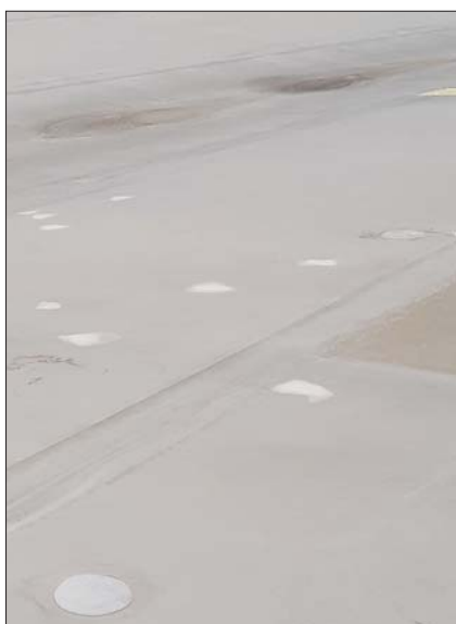
Рис. 1. Следы ремонтных работ Fig. 1. Repair work marks
