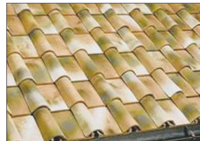
Рис. 2. Римская черепица Fig. 2. Roman roof tiles
