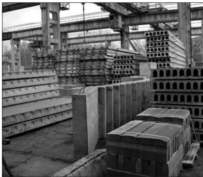
В октябре 2003 г. в г. Гусь-Хрустальный Владимирской обл. на ЗАО «Монолит» (бывший «Завод ЖБИ») вступил в строй региональный домостроительный комплекс мощностью 90–100 тыс. м 2 жилья (50 тыс. м 3 ЖБИ)
