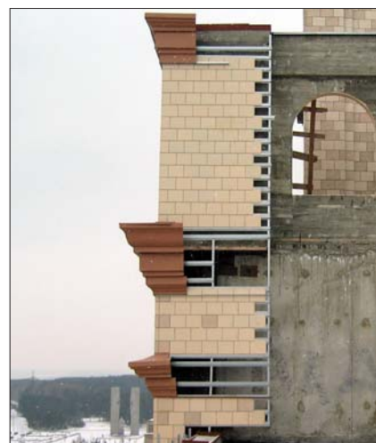
Фасадные кассеты «Геккон» успешно применены при новой отделке Южно-уральского государственного университета. Форма и цвет кассет полностью имитируют первоначальную облицовку керамической плиткой
