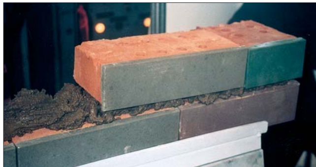
На глазах посетителей выставки каменщик выкладывал фрагмент стены из офактуренного керамического кирпича на стенде ООО «Производственная строительная компания»
