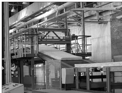
В сентябре 2003 г. в г. Серпухов Московской обл. запущен второй завод компании «URSA Евразия» по производству теплоизоляции на основе стекловолокна мощностью 20 тыс. т в год
