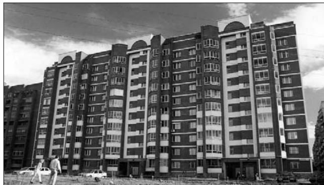
Жилой дом в Екатеринбурге по ул. Вилонова, 16. (Фото предоставлено редакцией журнала «Новый уральский строитель»)
