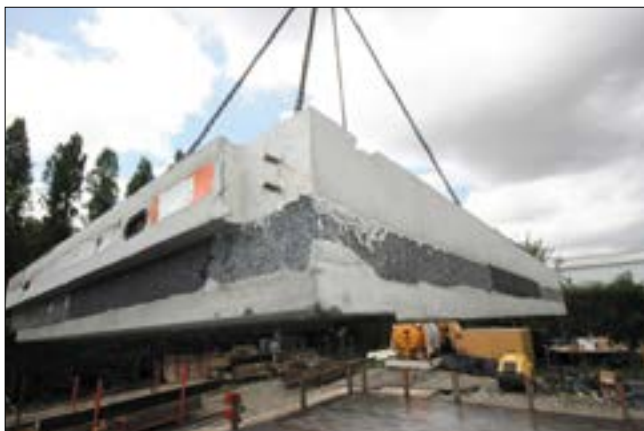
Монтаж плиты с гибкими стеклопластиковыми связями
