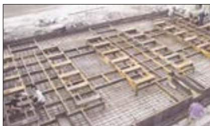
Рис. 4. Установка рамы формовочной машины
