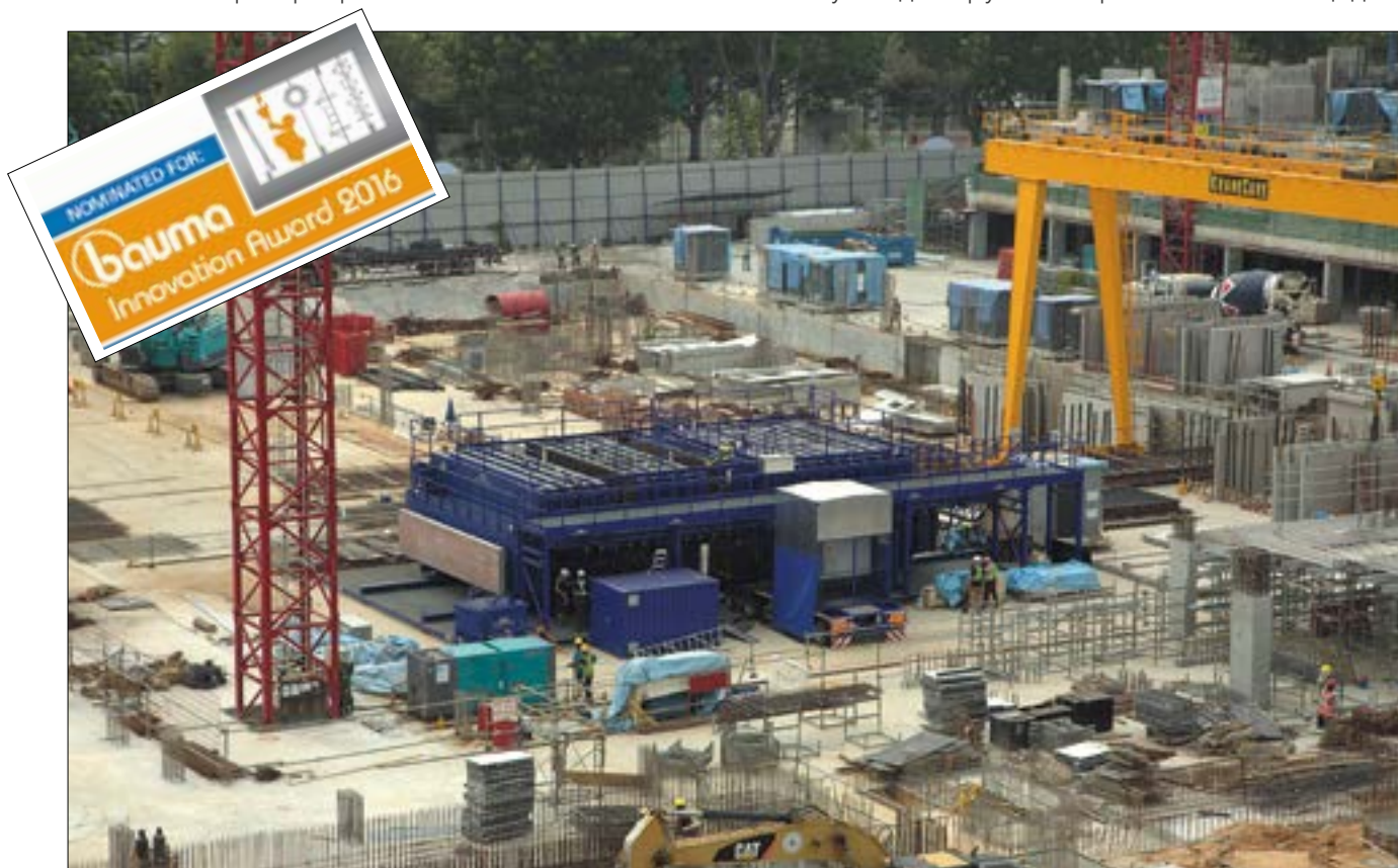
Использование мобильной кассетной опалубки на крупном строительном объекте в Сингапуре
