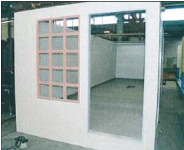
Рис. 6. Комнатный блок *Upcrete (объем бетона 6 м 3 , время заливки 25 мин). В основе технологии Upcrete лежит идея заливать бетон не традиционным способом сверху вниз, а закачивать снизу вверх. Работу над технологией проводила компания Reumann Technik в 2003 г., выполняя заказ на изготовление габаритного смотрового колодца. При вертикальной заливке бетона сборного элемента, имеющего сужение сверху и внизу, такая заливка сопровождалась нарушением качества поверхности «Ratec» ( www.ratec.org )
