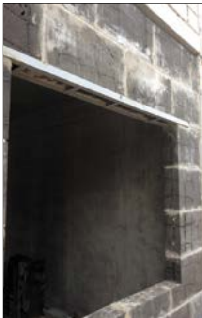
Рис. 2. Самонесущая стеновая конструкция из плитного пеностеклокристаллического материала
