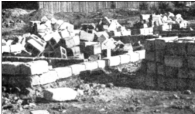
Рис. 1. Мелкоштучные гипсобетонные вибропрессованные блоки на строительной площадке (1951 г.)
