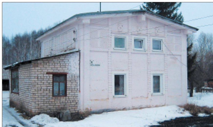
Рис. 4. Двухэтажное жилое здание из материалов на основе гипсовых вяжущих. Фундамент из гипсового камня; несущий каркас с колоннами из гипсобетонных блоков; наружные стены – сборные гипсовые плиты с засыпкой пазух шлаком; перекрытия из сборного железобетона на основе гипсового вяжущего
