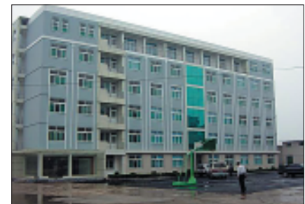
Рис. 11. Здание гостиницы с ограждающими и несущими конструкциями из материалов на основе гипсовых вяжущих. Китай
