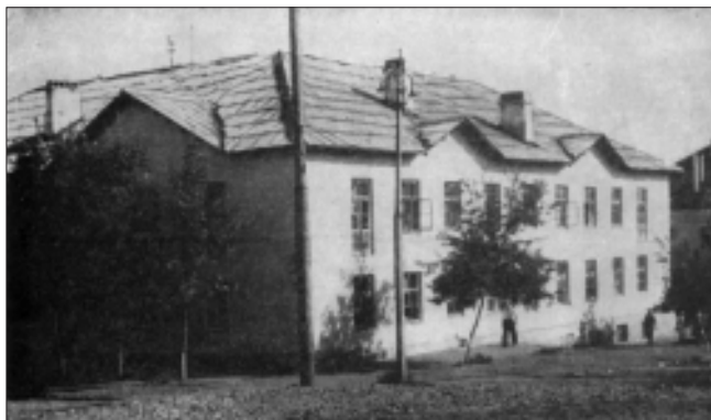
Рис. 3. Жилой дом в Уфе по ул. Калинина с несущими стенами из гипсоблоков (1956 г.)
