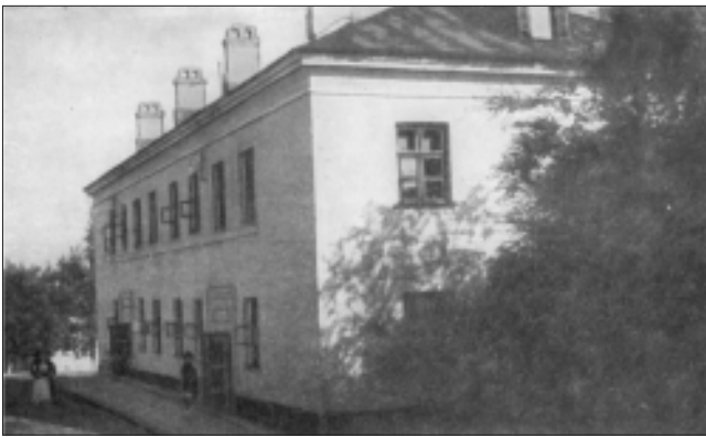
Рис. 5. Жилой дом в Уфе по ул. Нежинской, построен в 1942 г. (1956 г.). Стены, карнизы и отделка выполнены из гипса
