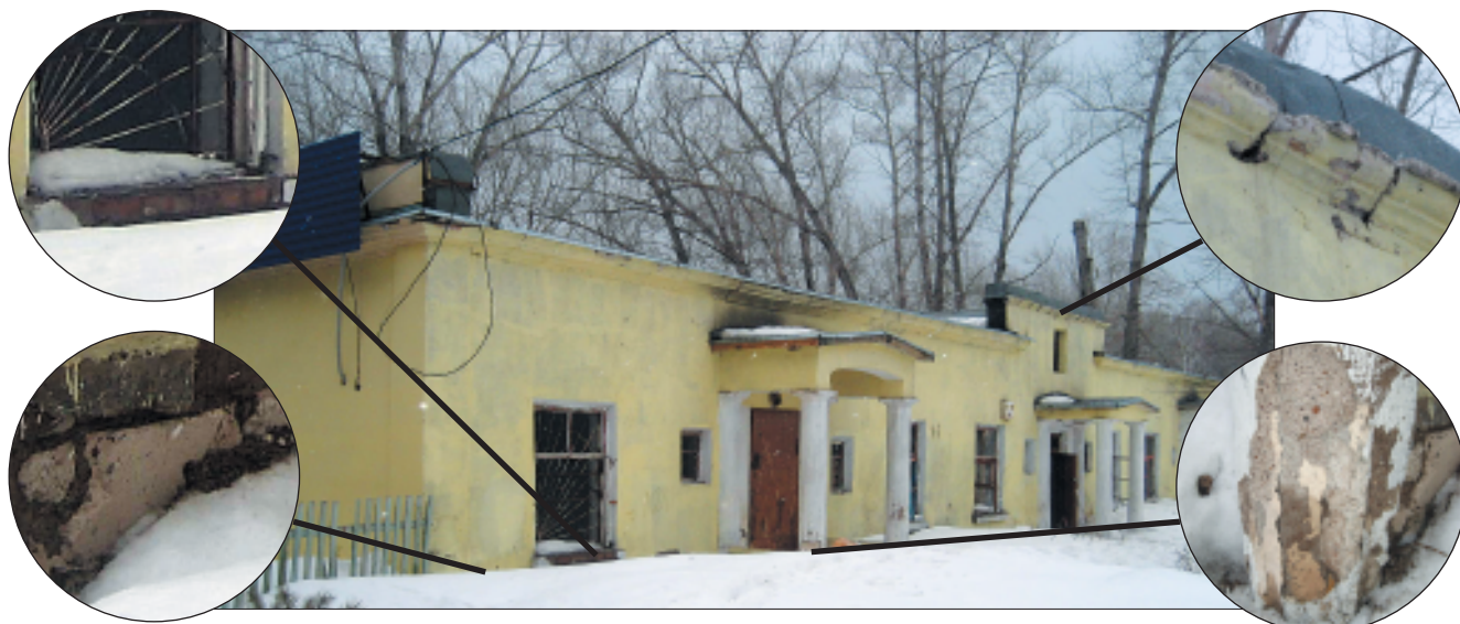
Рис. 3. Одноэтажное жилое здание из материалов на основе гипсовых вяжущих. Фундамент бутовый из гипсового камня, наружные и внутренние несущие стены из шлакобетона на основе гипсового вяжущего
