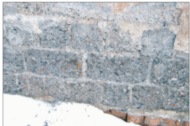
Рис. 8. Цокольная часть дома в Уфе по ул. Нежинской. Несмотря на постоянное промораживание и воздействие атмосферной влаги более чем за 60 лет эксплуатации, дефекты минимальны. Виден состав гипсобетонных блоков с заполнителем на основе топливных шлаков местных котельных
