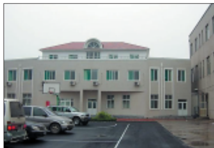
Рис. 10. Административное здание с ограждающими и несущими конструкциями из материалов на основе гипсовых вяжущих. Китай
