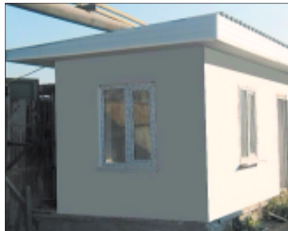
Рис. 7. Одноэтажное здание административного назначения. Наружные стены выполнены из гипсоборобетона и оштукатурены
