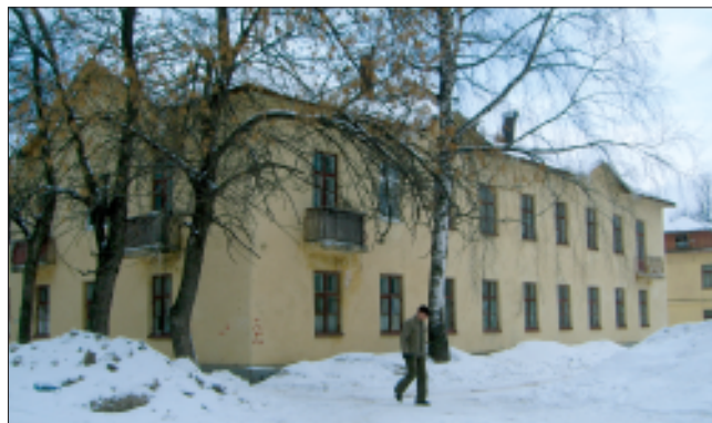
Рис. 4. Жилой дом в Уфе по ул. Калинина (2008 г.). При капитальном ремонте мелкоштучные фальшбалконы были заменены на стандартные с выносными монолитными железобетонными плитами
