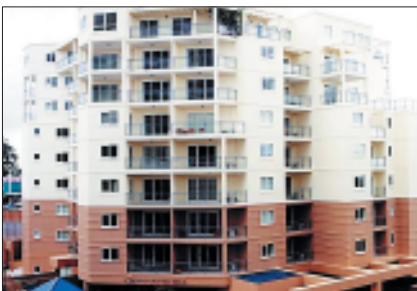
Рис. 9. Многоэтажный жилой дом с несущими и ограждающими конструкциями из материалов на основе гипсовых вяжущих. Австралия
