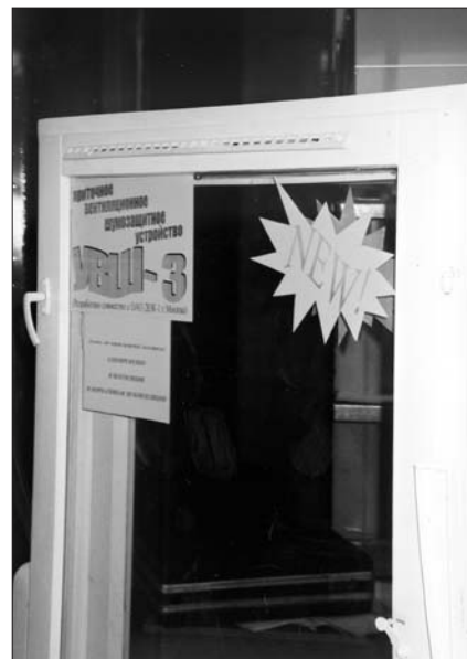
Новое решение вентиляционного шумозащитного устройства (УВШ-3) для отдельного окна (стекло-стеклопакет) не уменьшает светопропускающую площадь конструкции
