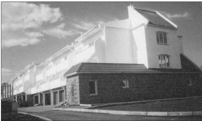
Рис. 3. 3-этажный жилой дом из сборно-монолитного пенобетона (г. Костанай)
