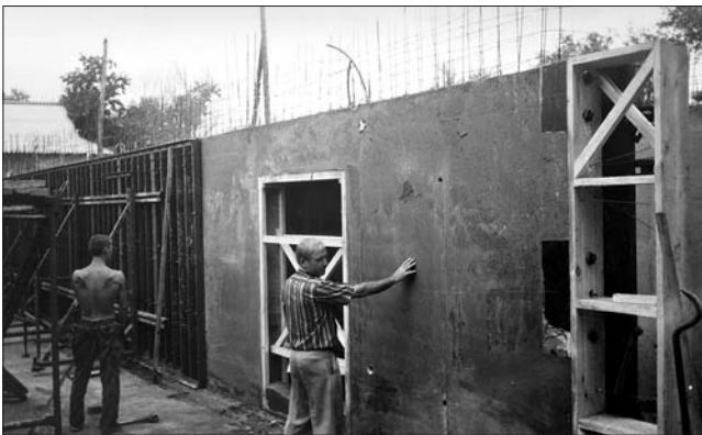
Рис. 1. Монолитная несущая стена из пенобетона «Унипор»
