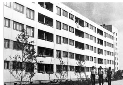
Рис. 2. Цельногазобетонный дом — прототип серии 1-468А в Павлодаре (ЛенЗНИИЭП), 1968 г.
