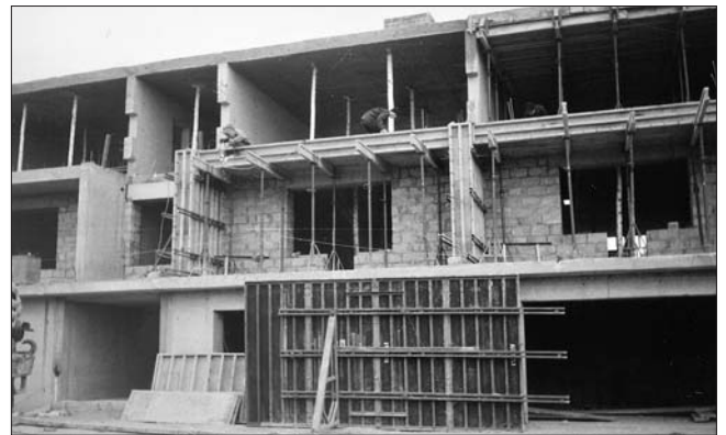
Рис. 2. Несущий каркас из пенобетона «Унипор»
